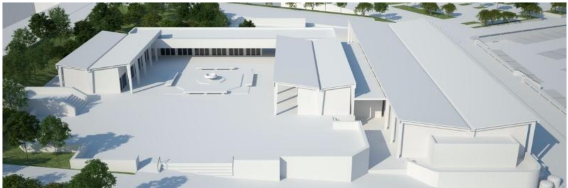
Figura 73 – Imagem do projeto para o Mercado de Estarreja (obra concluída) | Fonte: CM Estarreja
