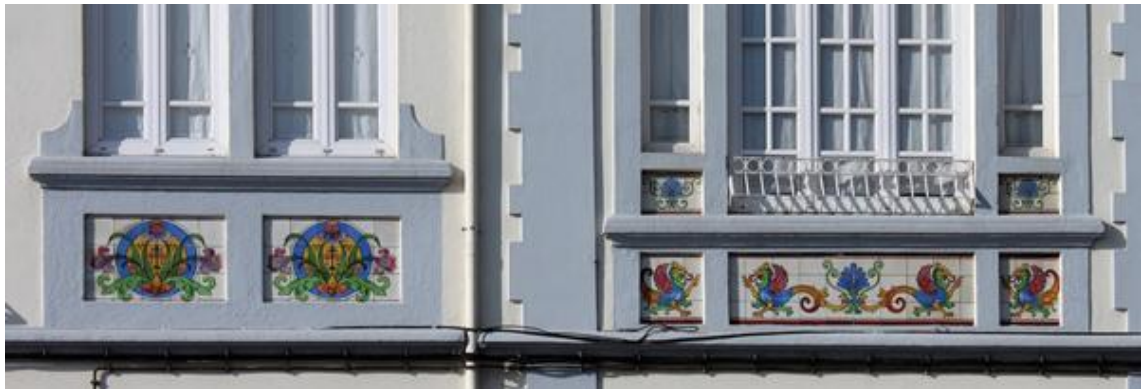
Figura 26 – Pormenor edifício no centro urbano de Estarreja | Fonte: CM Estarreja
