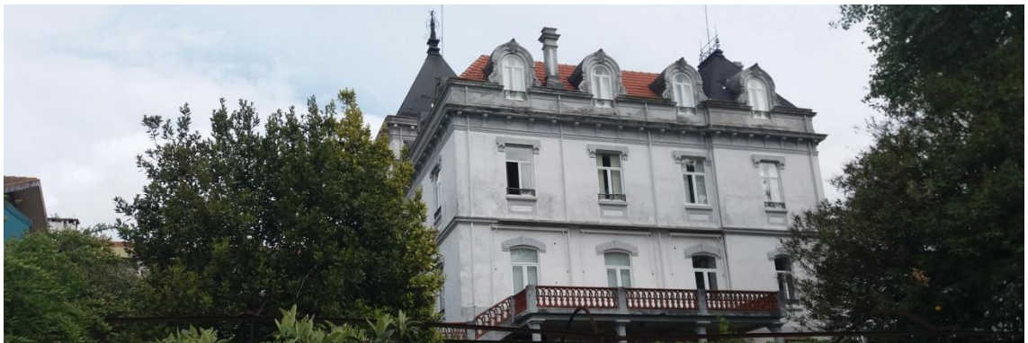
Figura 70 – Edifício histórico, de grande escala, no centro urbano
